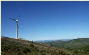
Slika 1. Primjer izgrađenog područja vjetroelektrane "Orlice"
